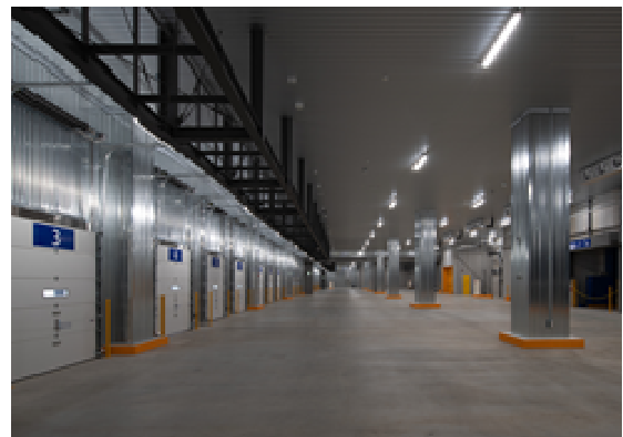
厚木低温物流センター 1階 荷捌きエリア
