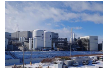
建設中の北上ガスセンター
