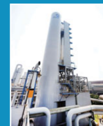
鹿島工場 8号プラント
