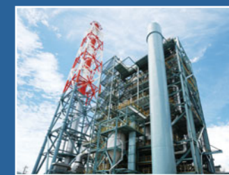
バイオマス発電設備
