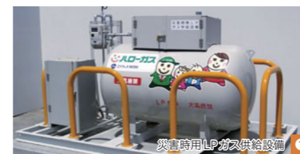
災害時用LPガス供給設備 ①
