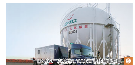
LPガス二次基地と100kW級移動電源車 ⑤
