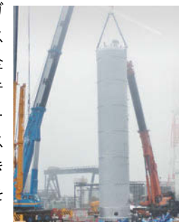
炭酸川崎工場施工風景
