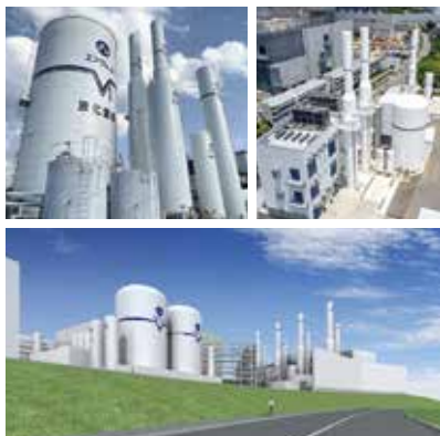
国内各地のガスセンター 左:広島県、右:長崎県、下:岩手県(建設中)
