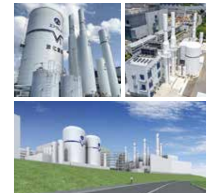
国内各地のガスセンター 左:広島県、右:長崎県、下:岩手県(建設中)
