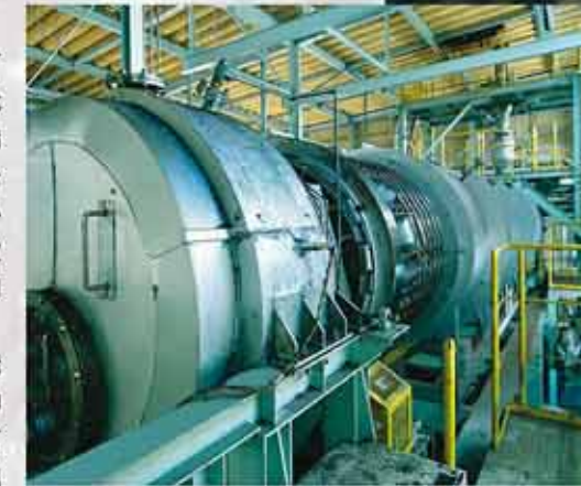
防府工場ベルパールプラント
