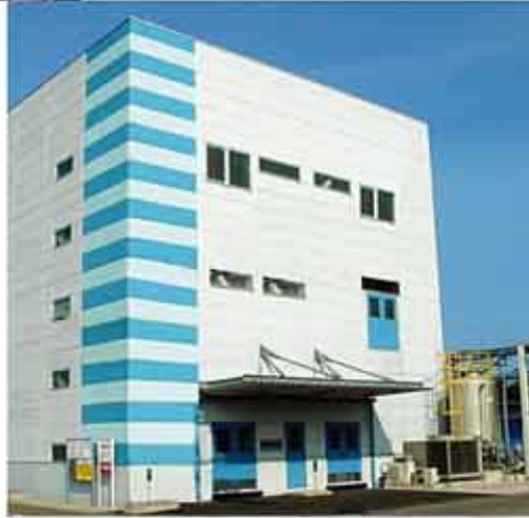
鹿島工場GMPプラント
