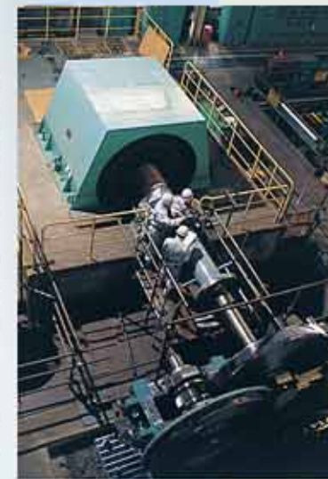
圧縮機の分解・整備
