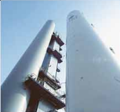
和歌山工場空気分離装置（12号プラント）
