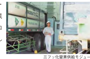
三フッ化窒素供給モジュール
