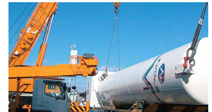
V1の設置工事
