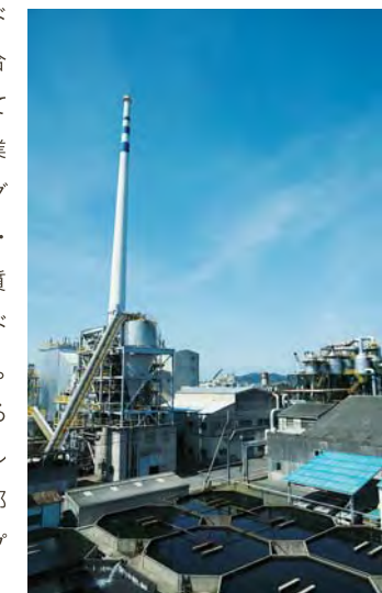
日本海水 讃岐工場 製塩プラント
