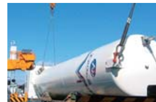
V1の設置工事
