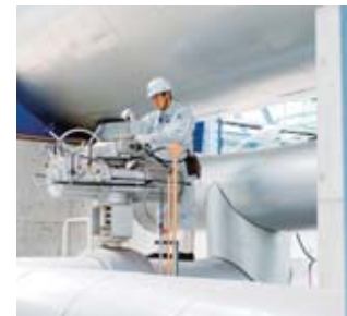
大型プラントの配管メンテナンス
