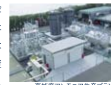
高純度アンモニア生産プラント
