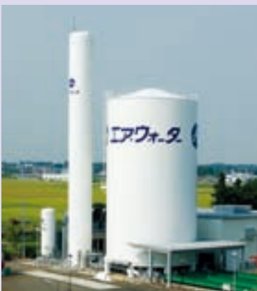
2004年に稼動を開始したVSU1号機(新潟)
