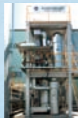
水素ガス発生装置 VH1号機
