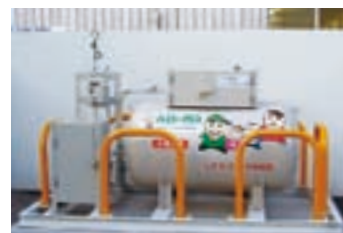
災害用LPガス供給設備
