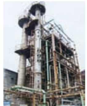
ケミカル和歌山工場
