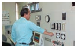
月1回の緊急遮断ゲートの作動確認
