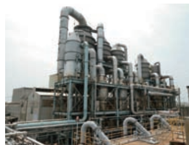
株式会社日本海水の 塩を作る設備
