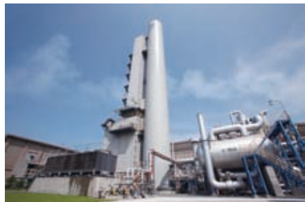
2008年2月に稼働した鹿島工場の7号プラント
