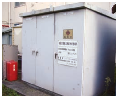
ケミカル鹿児島工場のPCB廃棄物保管場所
