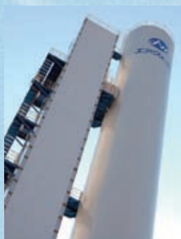
鹿島工場 7号プラント
