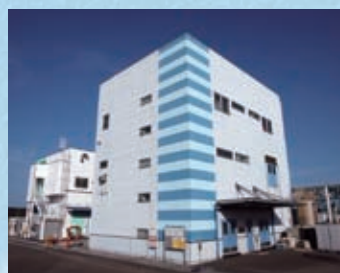
鹿島工場 GMP*プラント * GMP: 医薬品・製造品質管理規則
