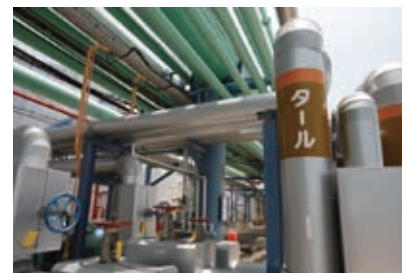
触媒脱臭装置
