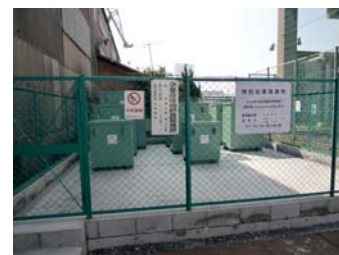
オンサイトカンパニー小倉工場 PCB 廃棄物保管状況
