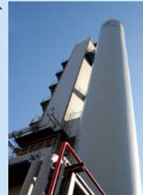
鹿島工場 7号プラント
