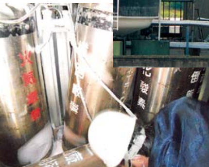
倒れたガスポンペを 固定する作業
