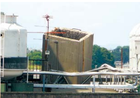
煙突が落下した 須賀川市の病院
