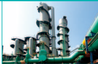
ガス精製プラント
