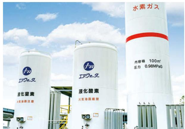
製造した水素の貯蔵タンク(右)と製造に用いる液化窒素と液化酸素のタンク(左・中央)
