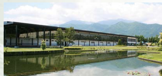
ゴールドパック(株) あずみ野工場
