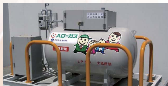
災害時用LPガス供給設備
