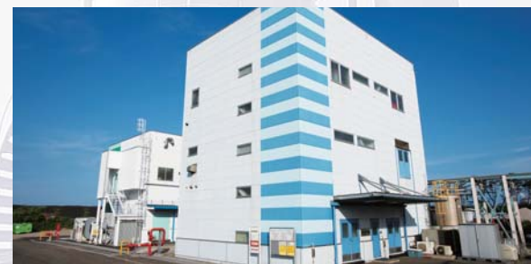
鹿島工場GMPプラント
