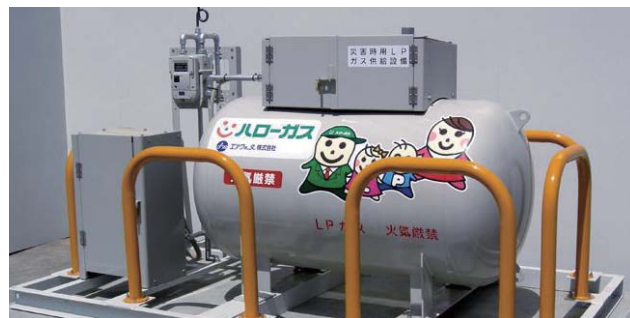
災害時用LPガス供給設備
