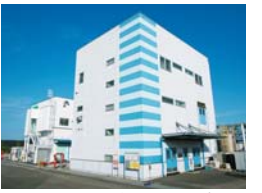
鹿島工場GMPプラント
