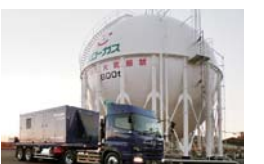
LPガス二次基地と100kW級移動電源車
