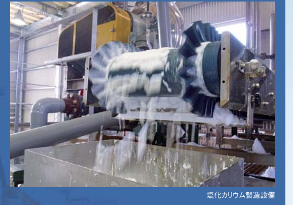
塩化カリウム製造設備
