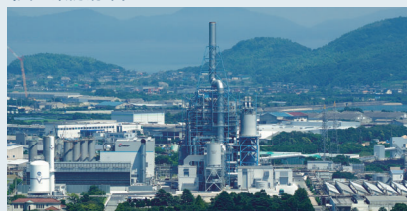
木質バイオマス・石炭混焼発電 発電能力 約11.2kW (2019年7月稼働開始)
