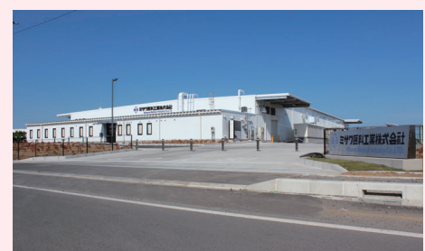
2020年6月に竣工した注射針の生産を行うミサワ医科工業株の新工場
