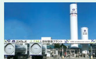
液化バイオメタンの製造工場
