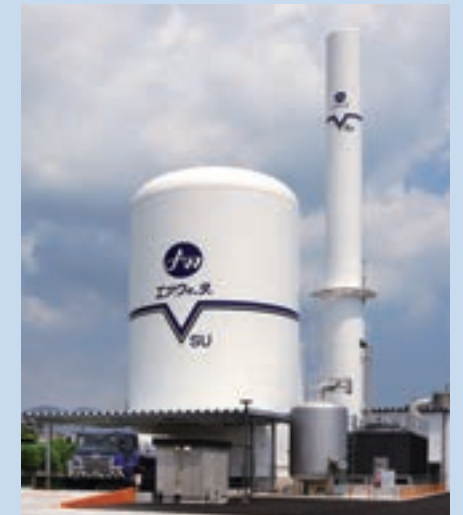
建設を予定するプラントと同型機
