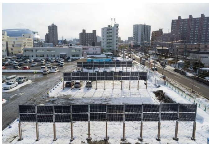
北海道札幌市豊平区の自社用地に垂直ソーラー発電システム「VERPA」の実証機を設置
