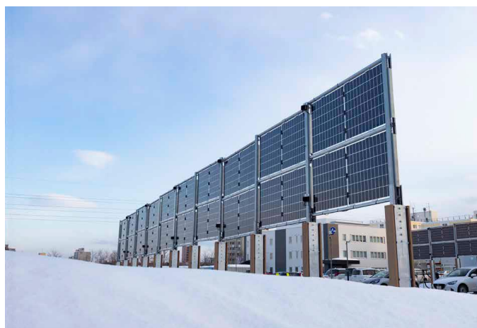
北海道札幌市豊平区の自社用地に垂直ソーラー発電システム「VERPA」の実証機を設置
