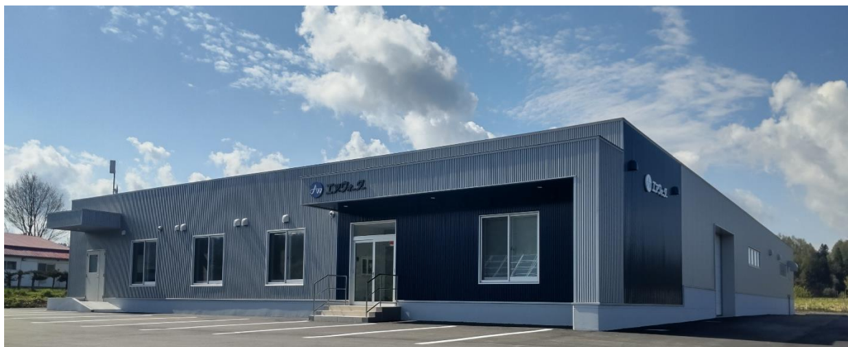
「杜のサーモンプラント・東神楽」外観
