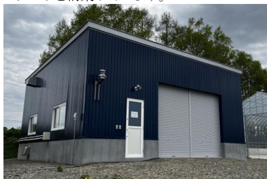
写真1 興部町に設置したメタン酸化技術開発研究棟
