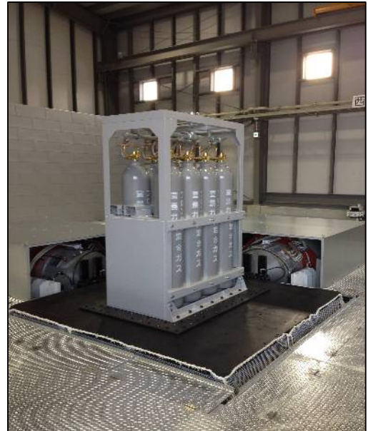
■ 消火設備を加振装置に搭載し試験を実施
