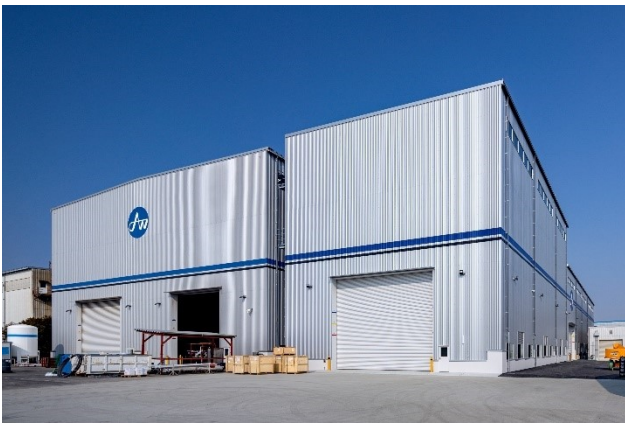
プラント製作工場 (右が新設工場)
