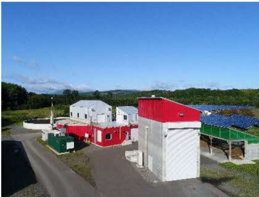
図 4 北海道興部町の興部北興バイオガスプラント
