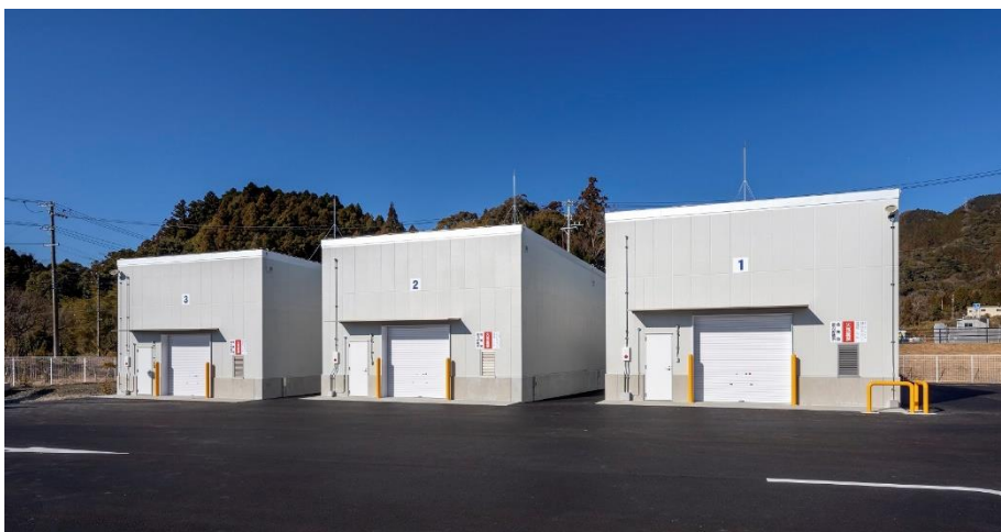
【危険物倉庫棟】
