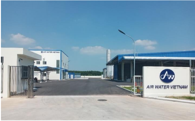
ハナム工場の外観
