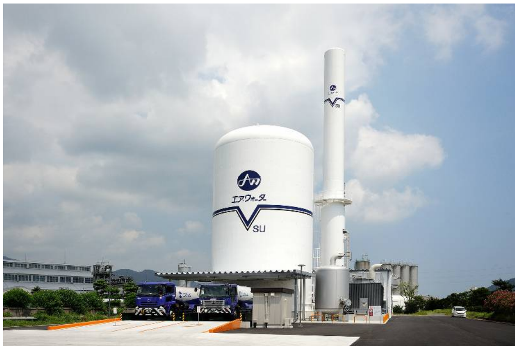
(建設を予定するプラントと同型機)
