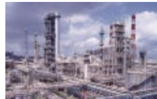
エア・ウォーター・ケミカルの蒸留プラント
